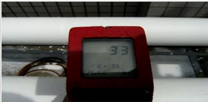
施工後 施工後 - 水管 33度
