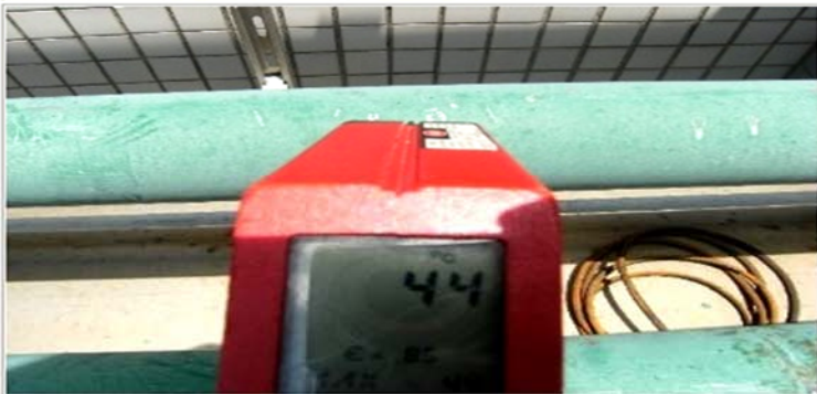
施工前 施工前 - 水管 44度
